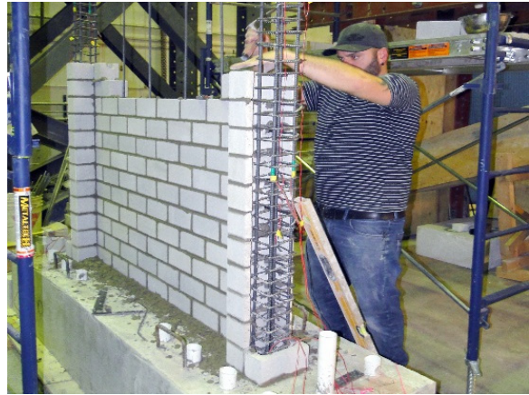
(d) Mid-height wall construction
