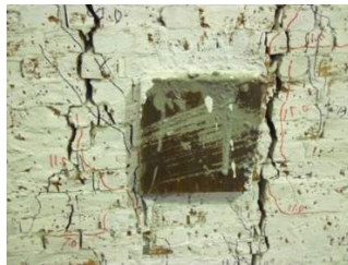
(d) Failure on Connecting Joint (Interstory drift 1/100)
